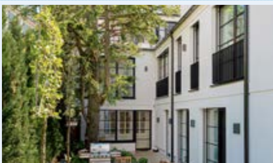
Zubau P Planung: AW Architekten Tragwerksplanung: zt-Büro holz bau technik Ausführung: Weissenseer Holz-System-Bau GmbH Bauherrschafft: Privat
