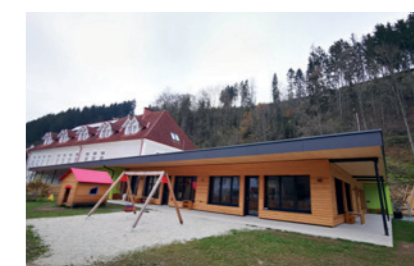
Erweiterung Kindergarten Waldbach
